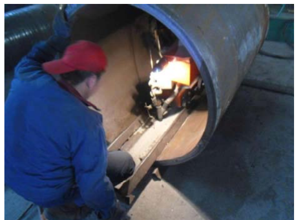
自动焊 Automatic welding
